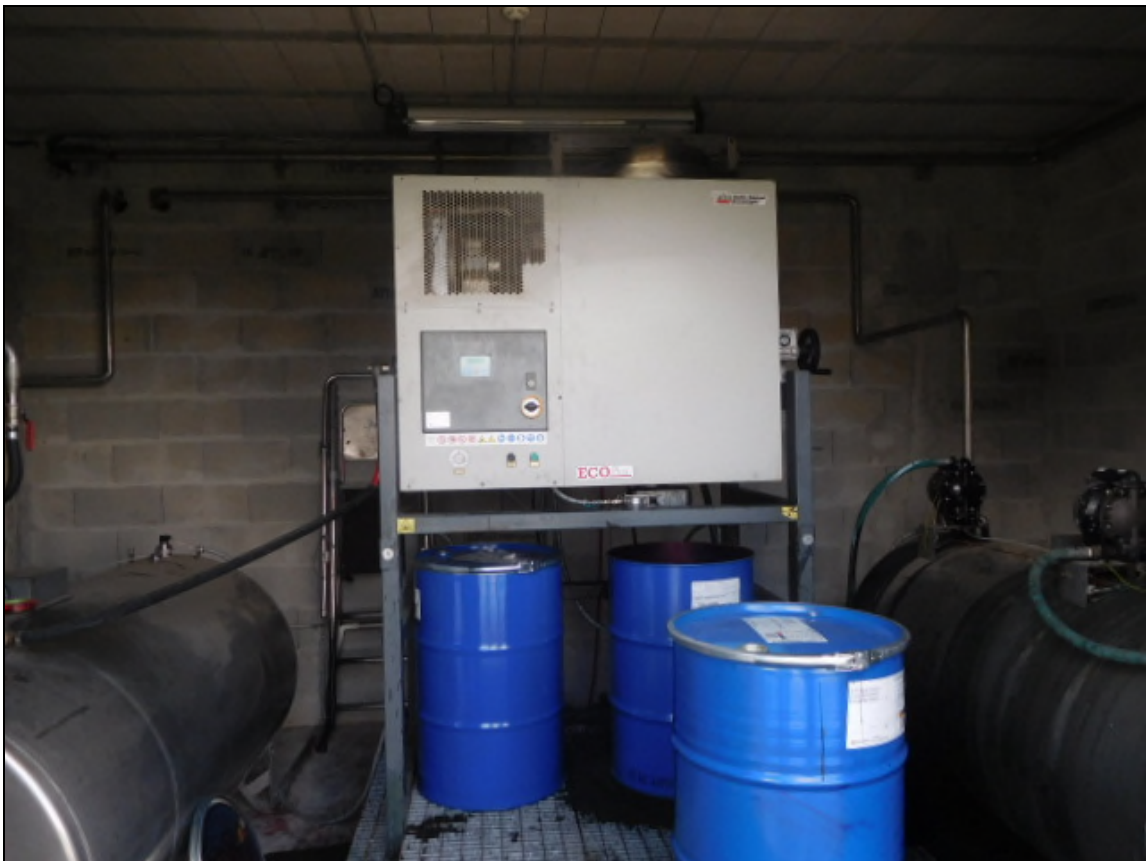
Local de régénération du solvant usagé
